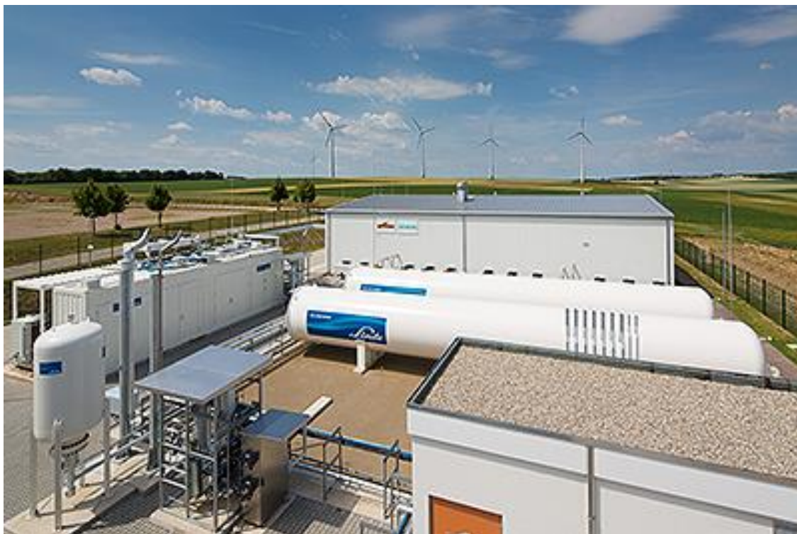
Afbeelding B2: Waterstofproductie (power-to-gas) op Industriepark Mainz
